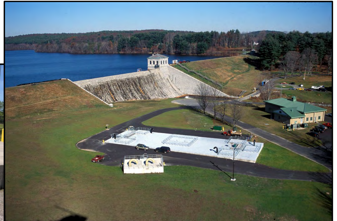
MWWST Shaft E
